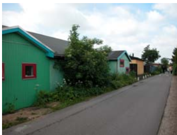
Al til- og frakørsel foregår ad den nordlige anlagte asfalterede vej til fællesarealet.
