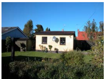
Et af de gamle havehuse, der er nyistandsat.
